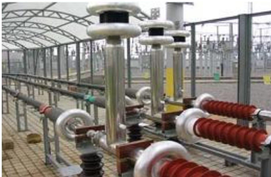
شکل (۲-۲۵): کابل انتقال برق ابررسانای HTS سه فازی بطول ۳۳ متر و ۳۵ کیلوولت/۲ کیلوآمپر در ایستگاه پوجی
