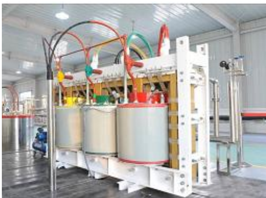
شکل (۲-۳): ترانسفورماتور HTS سه فاز ۶۳۰ کیلوولت آمپری
