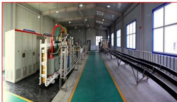
شکل (۲-۳۳): ایستگاه برق ابررسانای بیائین ۱۰.۵ کیلوولتی
