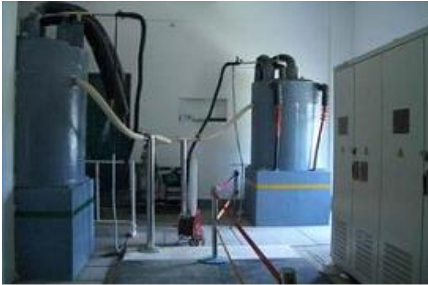
شکل (۲-۲۸): محدودساز جریان خطای نصب شده در ایستگاه لودی ۱۰ کیلوولت/۱.۵ کیلوآمپر
