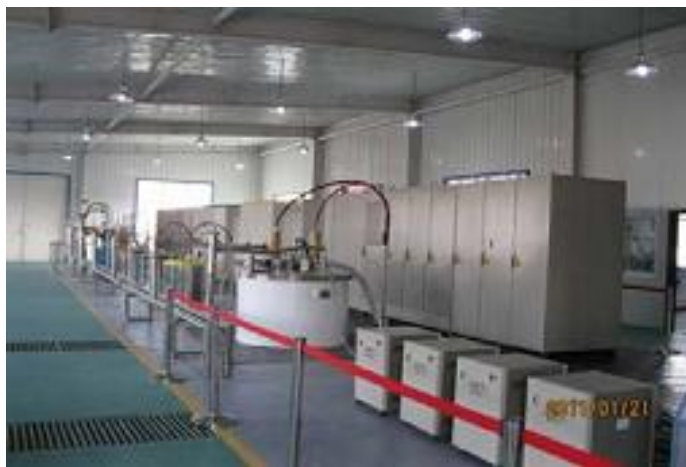
شکل (۲-۳۱): وسیله ذخیره انرژی ابررسانای دمابالا 1\text{MJ}/0.5\text{MVA}
