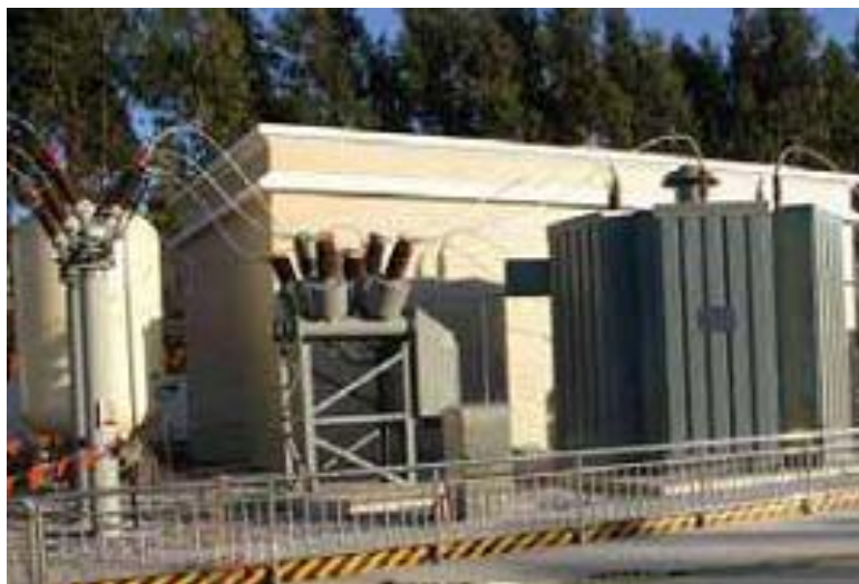
شکل (۲-۲۹): SFCL از نوع هسته‌ی آهنی اشباع شده ۳۵ کیلوولت/۹۰ مگاولت‌آمپر در ایستگاه پوجی
