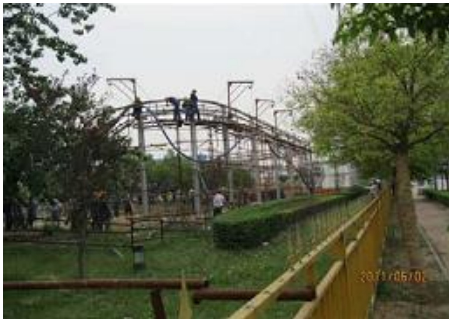
شکل (۲-۲۷): کابل HTS ۳۶۰ متری / ۱۰ کیلوآمپری در حال راه اندازی
